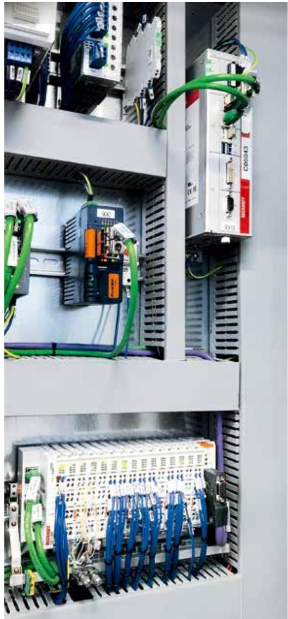
アイダエンジニアリングのプレス機を制御するベッコフの産業用PCおよびTwinCATソフトウェア(写真右上)と、EtherCAT IOターミナル(写真下)
